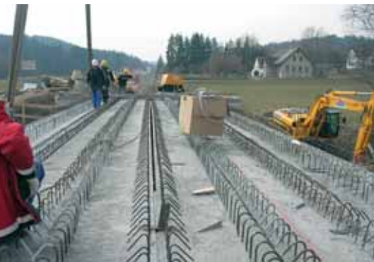
Vorbereitung der Fertigteile zur Ergänzung des Tragwerkes mit Leichtbeton-Ortbeton
