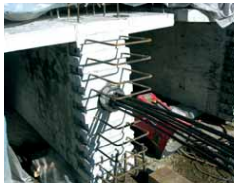
Vorbereitung der Fertigteile zur Ergänzung des Tragwerkes mit Leichtbeton-Ortbeton
